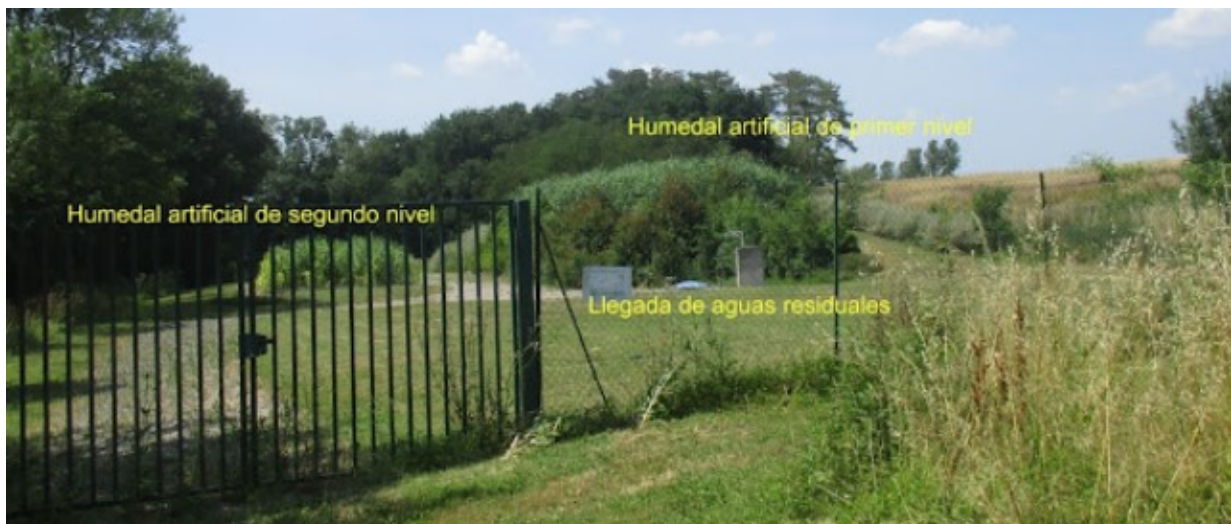
Fotografía 1. Humedal artificial de Parisot-Bousquet diseñado para 100 equivalentes de habitantes
