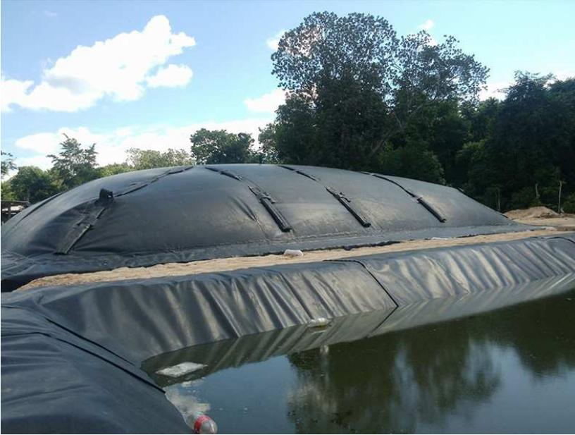
**Figura 14.** Biodigestor de geomembrana y cárcamo de recepción (Cortesía de Moncayo-Romero, 2020)
