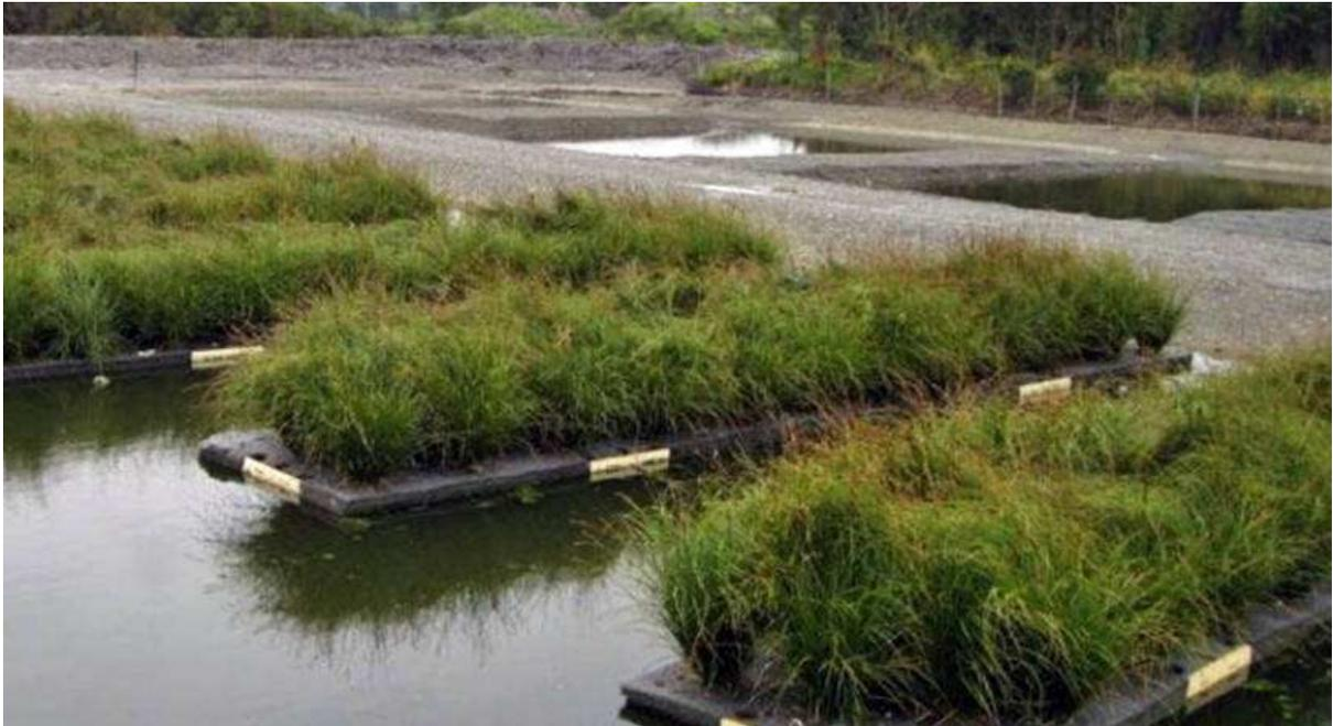
**Figura 10.** Humedal artificial de elementos flotantes (Cortesía de Ecofiltros, 2021)
