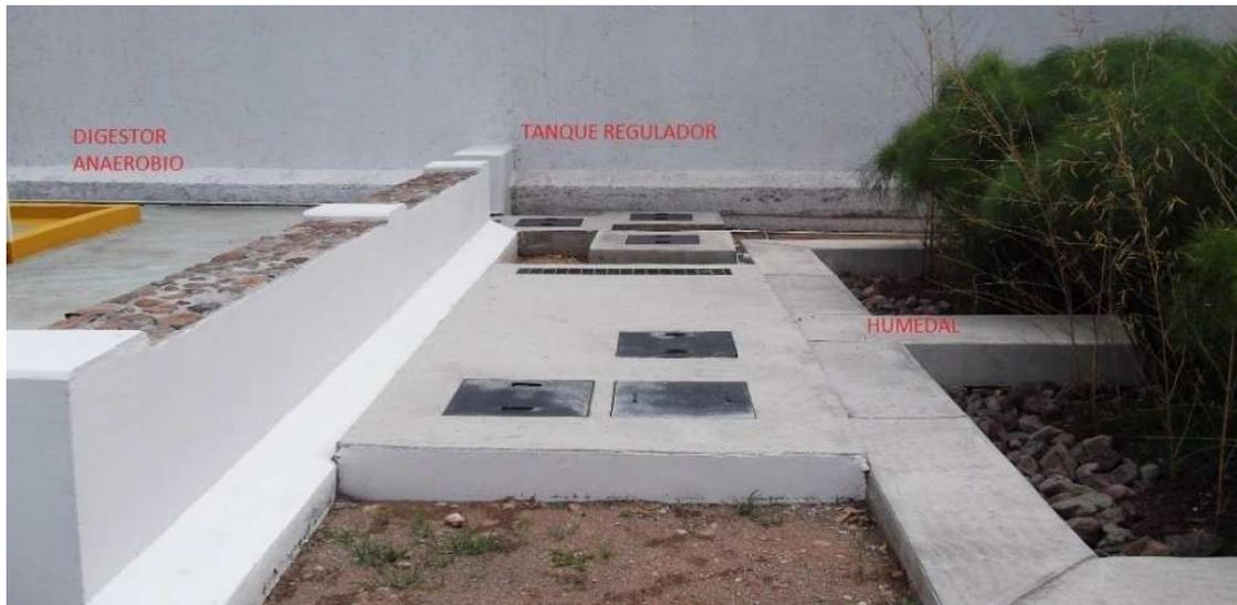
**Figura 4.** Sistema digestor más humedal
