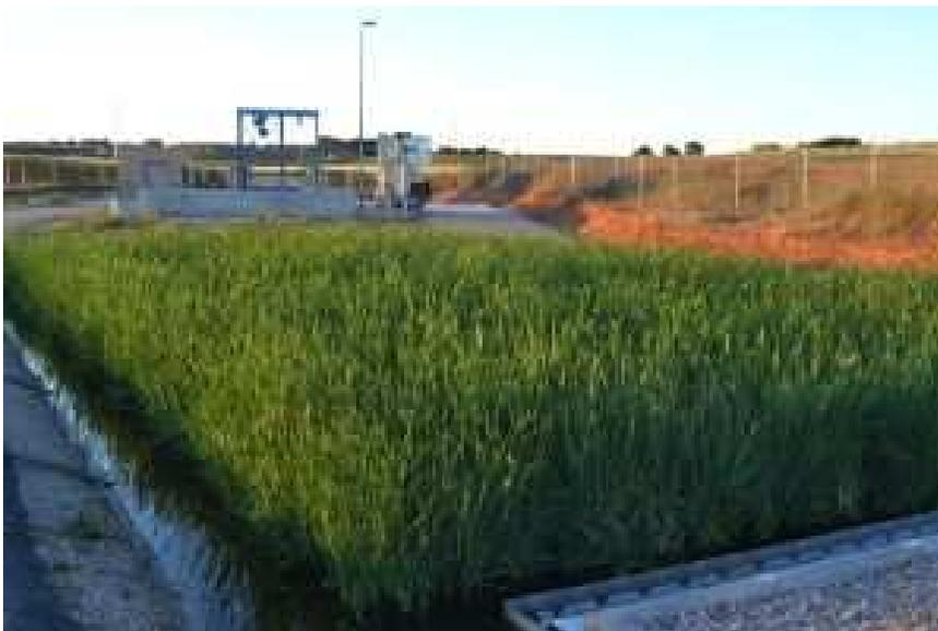
**Figura 17.** Humedal artificial subsuperficial con soporte de grava (Cortesía de Aquamarket, 2015)
