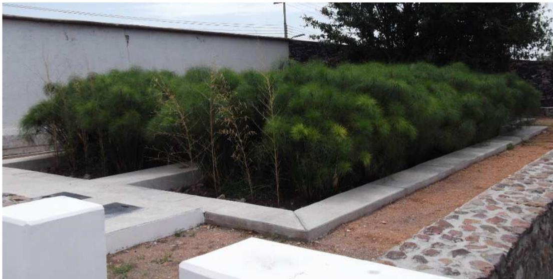
**Figura 5.** Humedal posterior al sistema anaerobio
