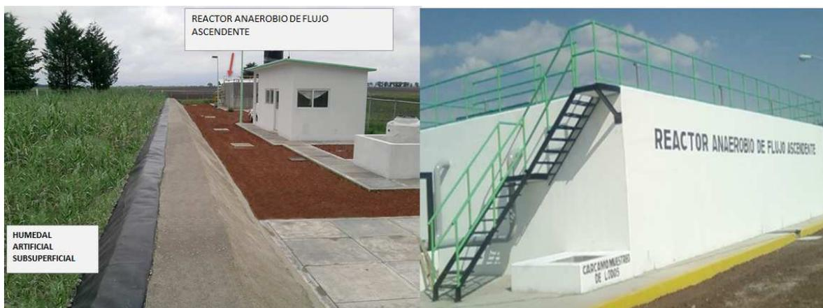
**Figura 3.** Reactor anaerobio de flujo ascendente con postratamiento de humedal artificial. construido con tecnología de la Comisión de Aguas del Estado de México o CAEM por la empresa Halcón Internacional S.A. de C.V.<sup>14</sup> (<https://halconinternacional.com/>)
