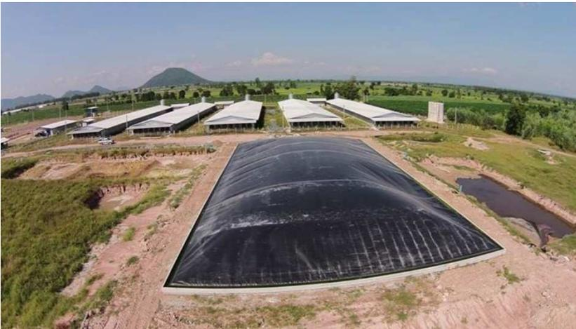
**Figura 15.** Biodigestor de geomembrana y cárcamo de recepción (Cortesía de Moncayo-Romero, 2020)
