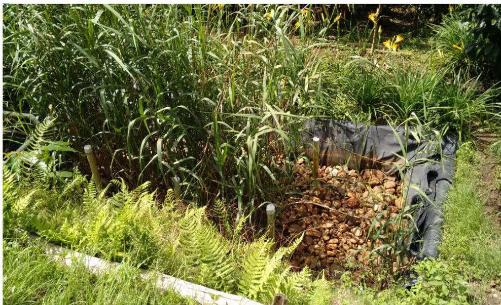
**Figura 2.** Sistema tipo humedal construido de flujo subsuperficial horizontal, HCFSSH, evaluado
